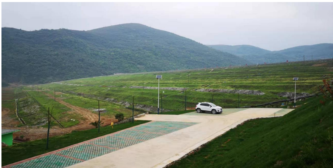
图 3.2-4 尾矿库现状坝体照片
