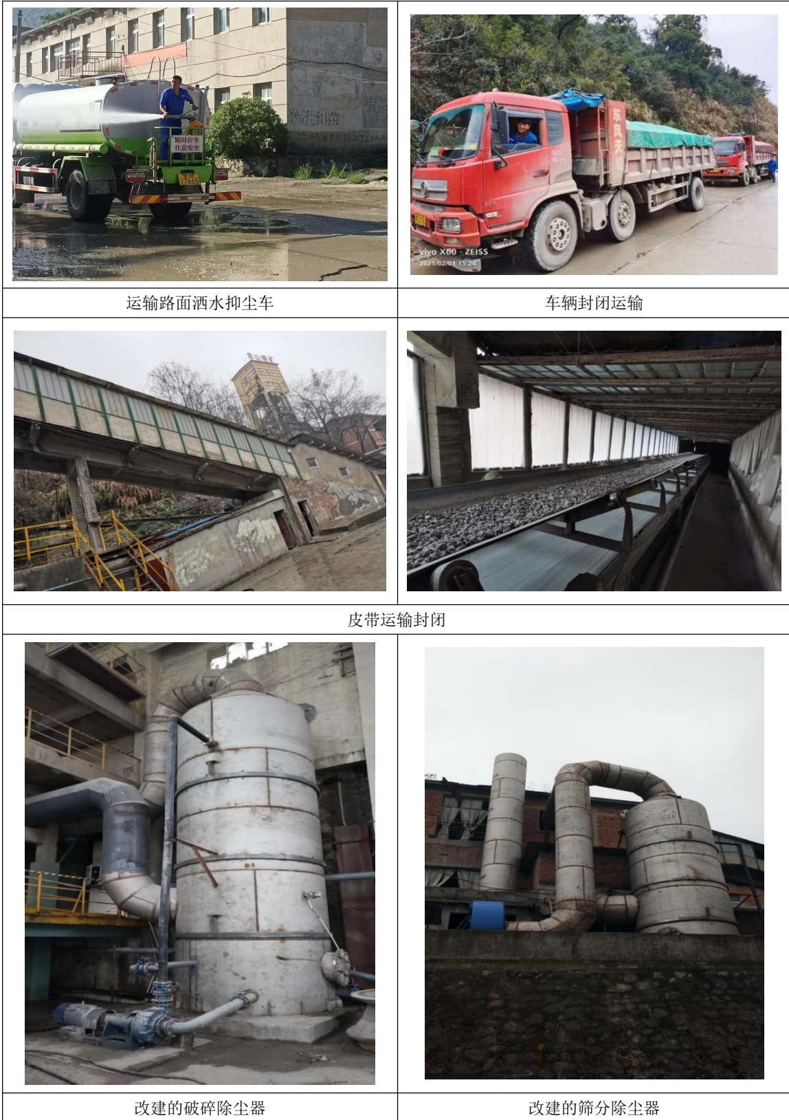
图 3.3-2 部分大气污染防治措施现场图
